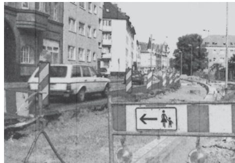
Bauarbeiten auf der Wunstorfer Straße
