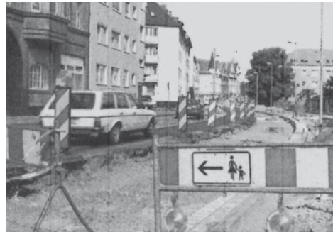
Bauarbeiten auf der Wunstorfer Straße
